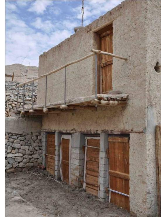
*Photo 3 - Le compost réalisé dans les toilettes sèches est prélevé une fois par an (dans la partie basse).*
